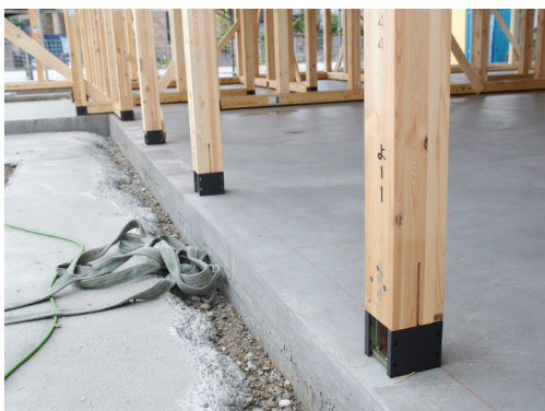
1階テラスの柱は直接基礎に設置
