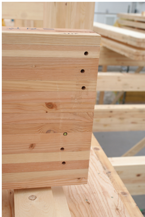
下部のドリフトピン穴は端部から約 84mm
