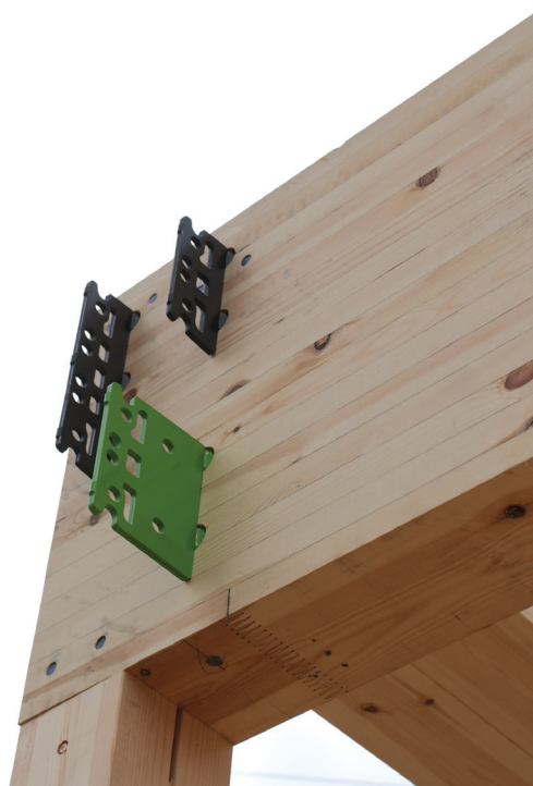
梁端下部に新商品D金物を設置
