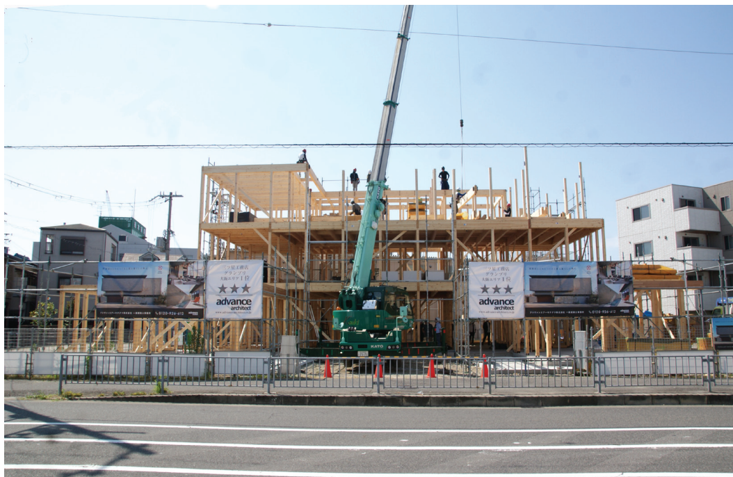
建て方工事中的の新社ビル：地域に開かれた新たな活動拠点として計画
